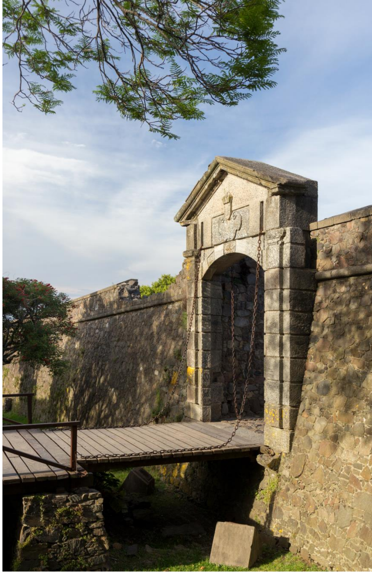
Portón de Campo y puente levadizo. Fotografía extraída de la Guía Patrimonio arquitectónico y urbano del Barrio Histórico de Colonia del Sacramento. 2017.
